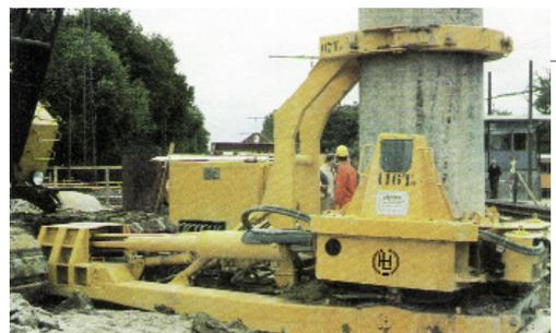
Funktionszylinder einer Verrohrungsmaschine (Werksfoto der Hans Leffer GmbH)
